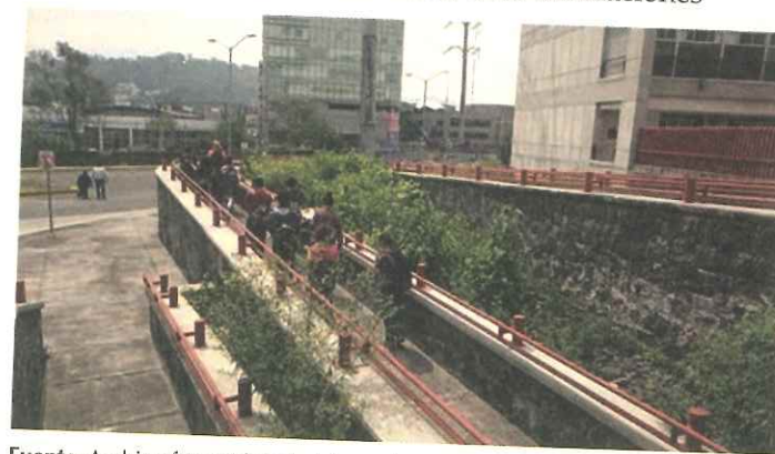
Fotografía 21. Dificil acceso a las instalaciones
