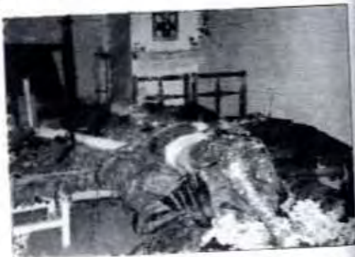
Los Cristos deteriorados fotografía de Gustavo Valencia
